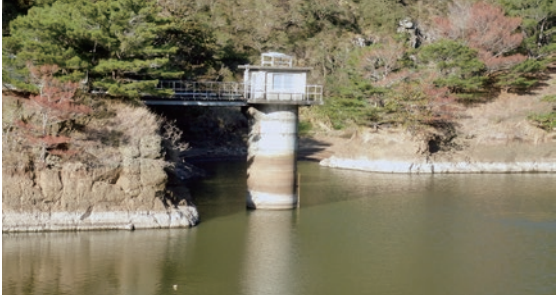
水位が下がり壁面があらわになった時雨ダムの取水塔
